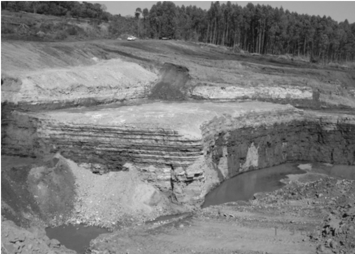
Figura 4 - Área em lavra. Foram retirados o solo e o argilito, que foram recuperados por carregadeira e caminhões.
